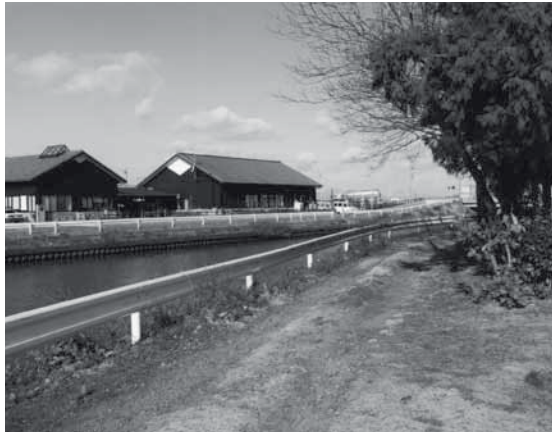
鵜戸川対岸から見た道の駅
